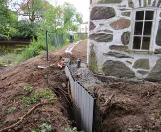
För att säkerställa att vatten från dammen inte tränger in i den gamla smedjan, har en miljöspons grävts ner i en jordvall som såddes med gräs i våras. FOTO: GREEN LANDSCAPING
