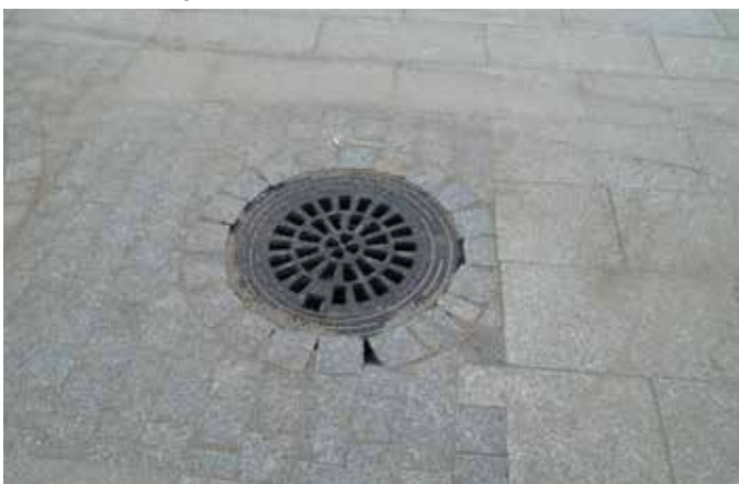
Anläggaren saknade kunskap om stensättning runt brunn.
