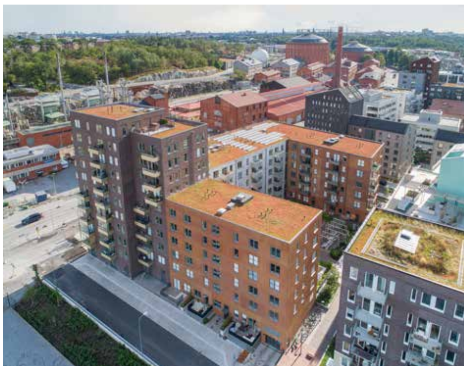
Kvarteret Koppången i Norra Djurgårdsstaden har flera tak som kombinerar sedummattor och solpaneler. FOTO: ÅKE GUNNARSSON, VUE
