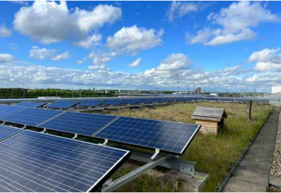
Here East, Stratford, byggdes inför OS i London 2012. Ett mycket bra exempel på ett biotop-tak med fokus på hög biodiversitet samtidigt som en stor del av takytan täcks av solceller.
