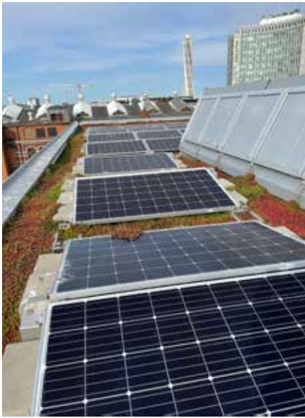
Låglutande solpaneler kombinerade med sedum på kvarteret Ubåten i Malmö.
